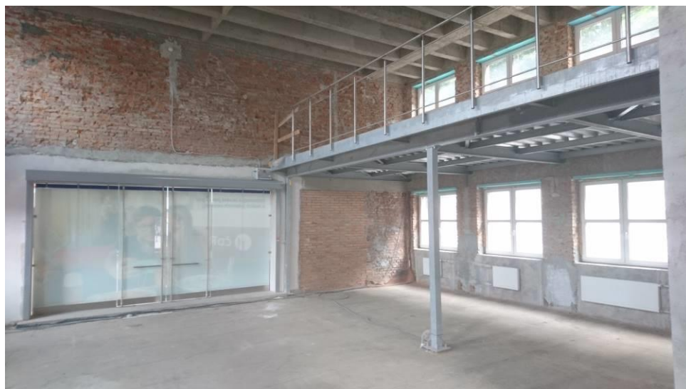
Foto – halový prostor 1.NP s vloženou OK galerií
