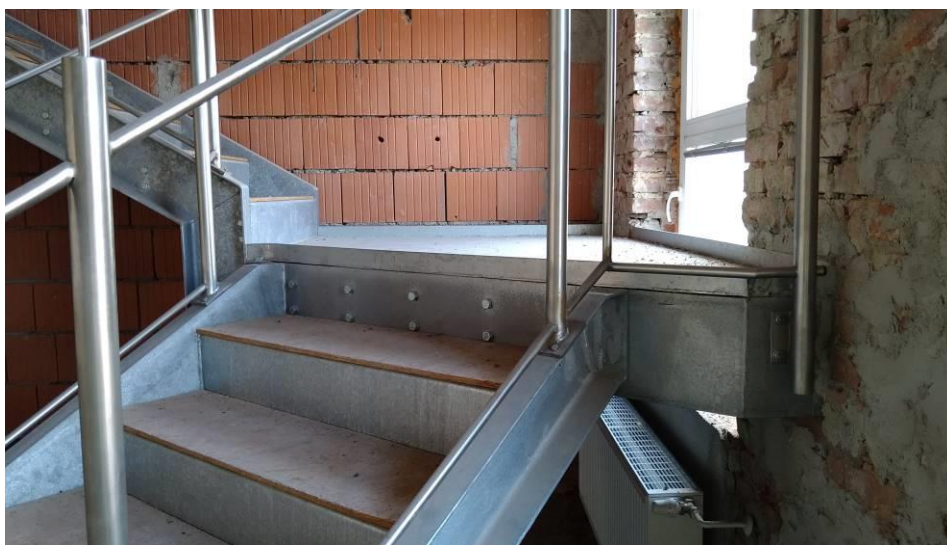
Foto – detail konstrukce schodiště na galerii
